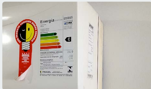
A foto mostra um aparelho de Categoria "C" (etiqueta branca) com o selo PROCEL (etiqueta vermelha), sendo incompatível, pois o Selo PROCEL só deve aparecer em aparelhos com Categoria "A"
